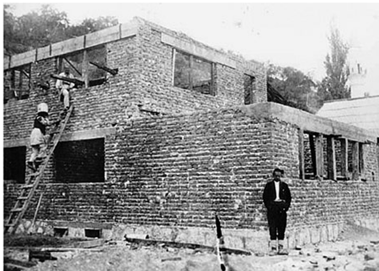
gradnja kuće u Zvorniku
